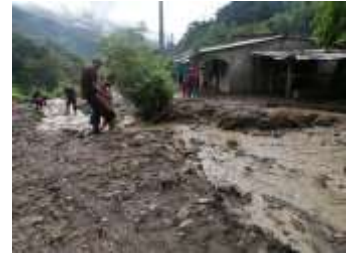
Die Infrastruktur – nicht nur in Jolomché wurde vom Hochwasser arg in Mitleidenschaft gezogen.
